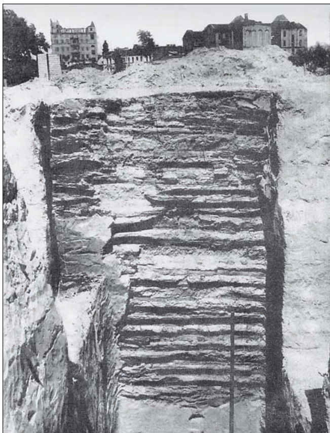
Дубовый сруб внутривальной конструкции «города Ярослава»
