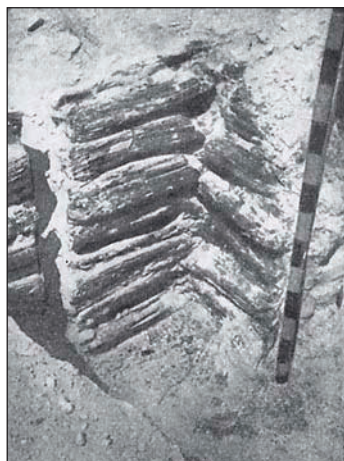
Торцы бревен, соединенные «в обло», внутривальная конструкция «города Ярослава»
